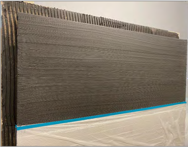
GLAPOR Systemkleber mit Besenstrich als Putzimitation
