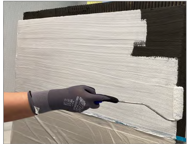
GLAPOR Systemkleber mit Remmers PA Color Fassadenfarbe
