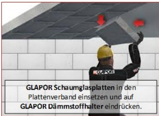
GLAPOR Schaumglasplatten in den Plattenverband einsetzen und auf GLAPOR Dämmstoffhalter eindrücken.
